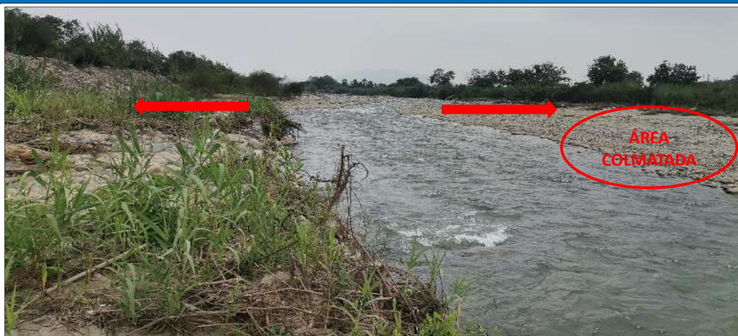
FIGURA N°01: RIO CHANCAY - HUARAL COLMATADO EN EL SECTOR BARRAJE HUANDO - PISQUILLO, CON LA PRESENCIA DE: PLANTAS, ARENA FINA Y MATERIAL GRANULAR; LAS CUALES DEBEN SER DESPLAZADOS HACIA AMBOS MARGENES PARA MANTENER SU SECCIÓN HIDRÁULICA .
