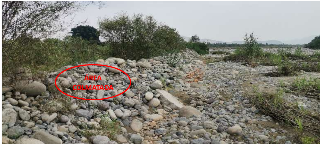
FIGURA N°02: MARGEN IZQUIERDA DEL RIO CHANCAY - HUARAL CON DIQUE DE PROTECCION EN MAL ESTADO, POR TAL MOTIVO ES VULNERABLE A LAS VELOCIDADES EROSIVAS DEL RIO PRODUCIENDO DESBORDOS DEL CAUCE DEL RIO, EN EL SECTOR BARRAJE HUANDO - PISQUILLO DEL DISTRITO DE HUARAL - AUCALLAMA.
