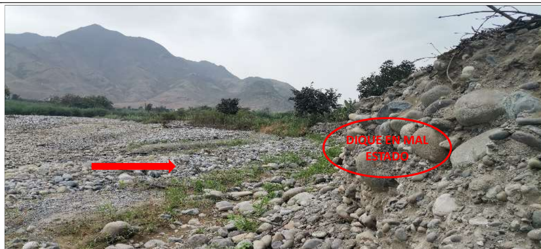
FIGURA N°04: DIQUE EXISTENTE DE MATERIAL PROPIO EN MAL ESTADO EN EL MARGEN IZQUIERDO DEL RIO CHANCAY - HUARAL, ZONA VULNERABLE EN EPOCAS DE AVENIDAS.
